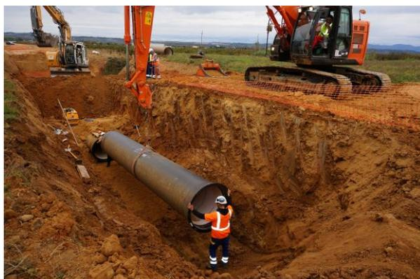
D'une longueur de 7,8 km et d'un diamètre de 1000 mm, la canalisation implantée au sud de Lieuran-lès-Béziers entre Corneilhan et Bassan est en cours de pose. Elle va permettre d'alimenter, en 2015, le nouveau périmètre agricole irrigué du Nord-Est-Béziers.
