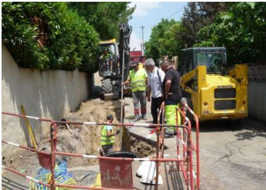
D'autres petits travaux sont également effectués par l'entreprise La Triplette tels que le remplacement de 11 branchements plomb, à l'origine de nombreuses fuites.
