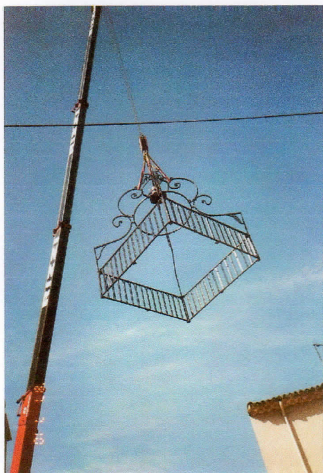
Élévation de l'ensemble du campanile, sur le point d'être posé sur le beffroi
