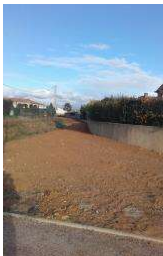
Passage de la conduite AEP en bordure du Ruisseau des « Combes »
