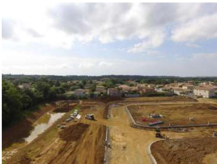
Les photographies aériennes permettent de localiser l'implantation des futures voies de circulation, les deux bassins de rétention des eaux pluviales ainsi que le lot réservé à la construction des logements sociaux.
