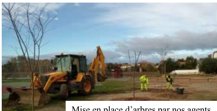
Mise en place d'arbres par nos agents
